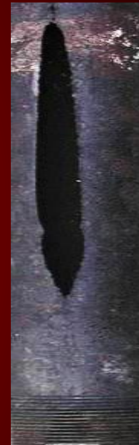
Fissura devido à Haste
